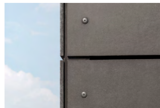
Synlig montering av fibersementplater med fargede nagler
