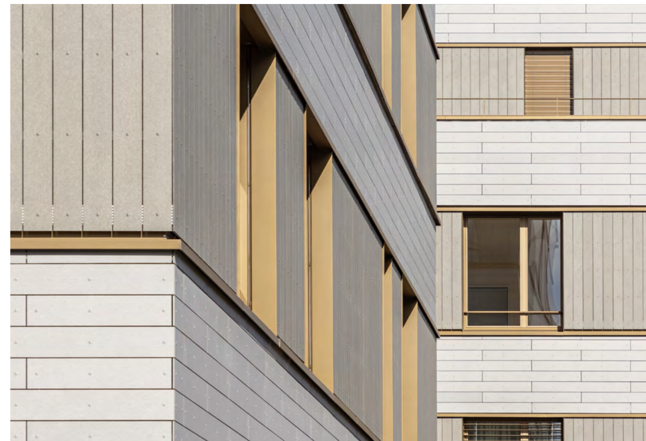
MFH, Zuzwil, Švýcarsko. Architekt: Trunz + Wirth AG, Henau, Švýcarsko. Autor fotografie: Meraner & Hauser OHG/SNC, Bolzano, Itálie.
