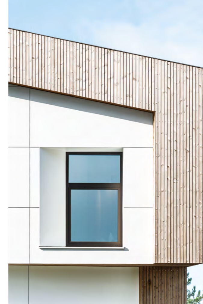
Niewidoczny montaż za pomocą systemu Swisspearl Sigma 8 Pro
