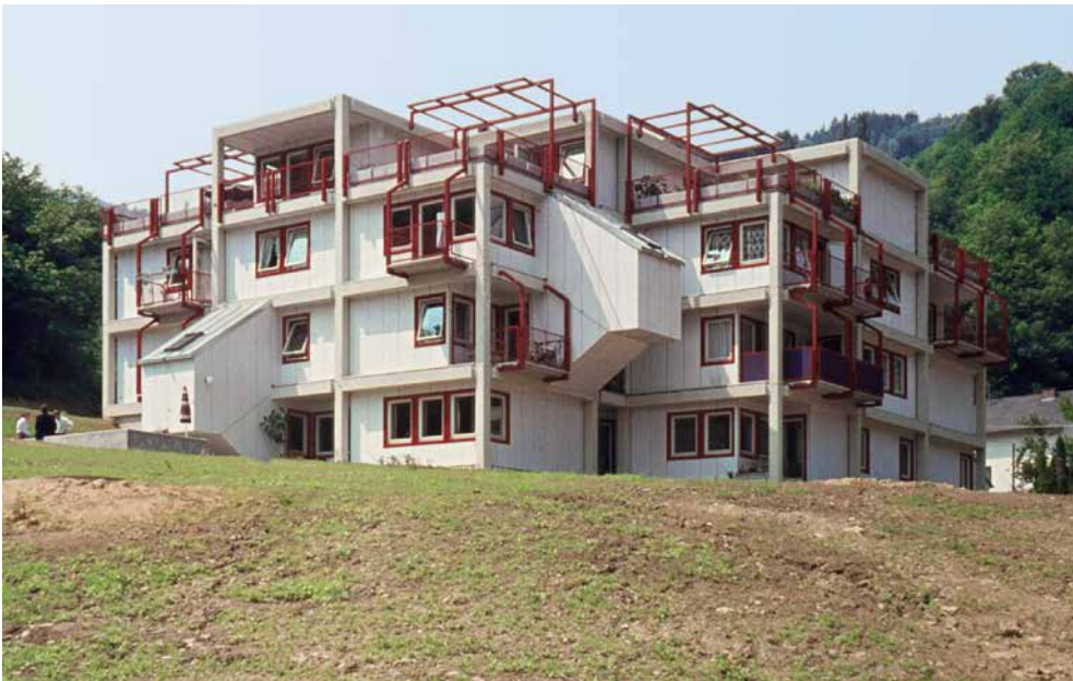
Realisierter Versuchsbau in Linz, Aufnahme von 1978.
