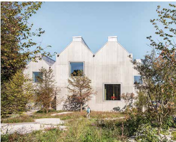
Feine Kanneluren in der Betonfassade prägen die äussere Erscheinung des Naturmuseums in St. Gallen.
