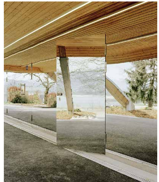
Umbau und Sanierung einer öffentlichen Sanitäreinrichtung auf der Raststätte La Gruyère.
