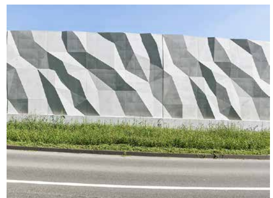
Die Stützmauer in Riederberg erhält durch die modulare Metallverschalung eine skulpturale Anmutung.
