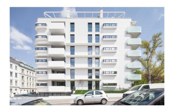
Die gesamten Fassadenflächen wurden mit Faserzementplatten in Großformaten verkleidet. Absolut einzigartig sind die gerundeten Gebäudekanten mit einem Radius von ca. 80cm, die mit gekrümmten Sonderelementen verkleidet wurden, wodurch die einzelnen Fronten fließend ineinander übergehen. Ausschlaggebend für die Materialwahl waren die Faktoren Hochwertigkeit, Langlebigkeit und Nachhaltigkeit.
