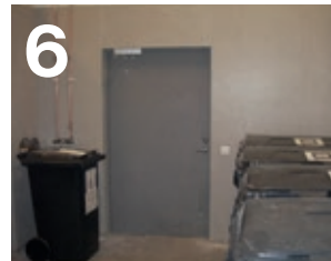
6 Innertak och väggar förråd och soprum
