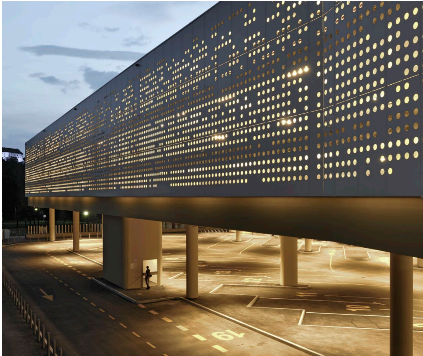
Busstation, Velenje/Slowenien. Largo, Farblinie: Carat. Architektur: Guzic Trplan Arhitekti D.O.O., Ljubljana/Slowenien. Fotografie: Miran Kambic, Radovljica/Slowenien
