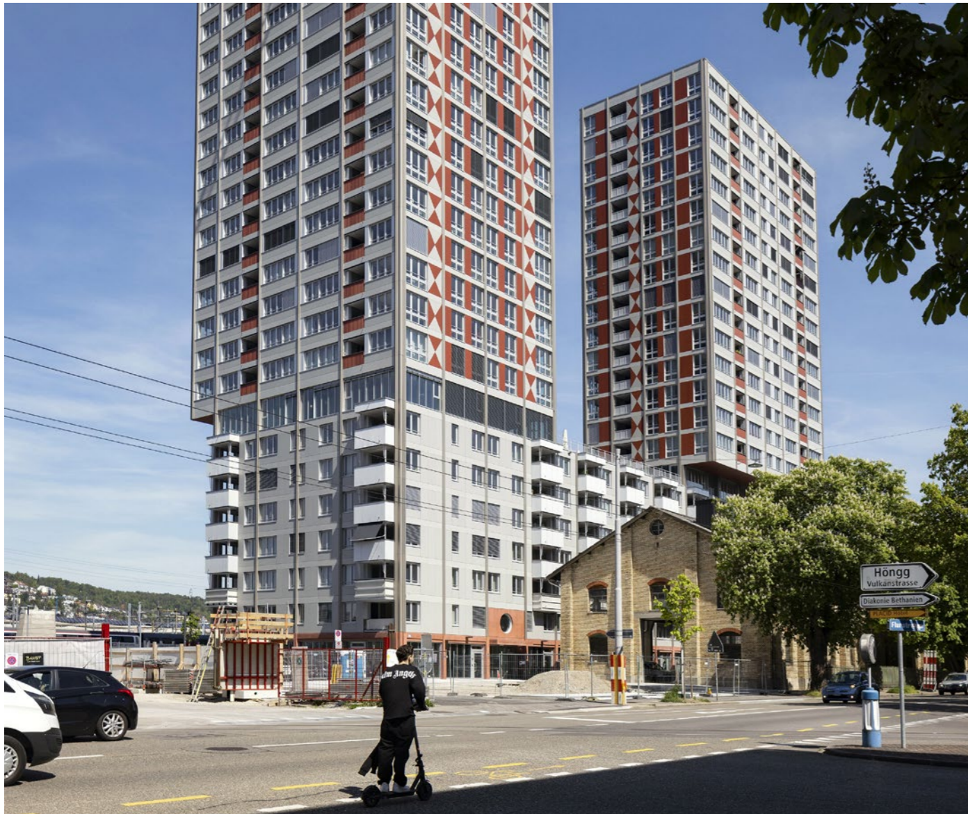
Oben: Letzi Turm, Zürich. Largo + Ondapress-36, Farblinie: diverse. Architektur: ARMON SEMADENI ARCHITEKTEN, Zürich. © SBB CFF FFS S. 24/25: Einfamilienhaus, Ruswil. Largo, Farblinie: Vintago. Architektur: howaldarchitekten GmbH, Baden. Fotografie: howaldarchitekten GmbH, Baden
