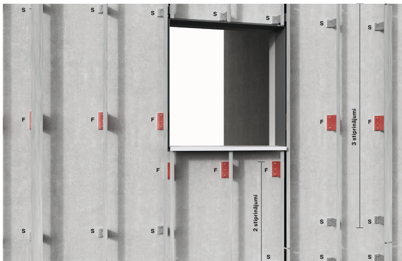
Sarkanie stiprinājumi ir stiprinājumi, kuriem ir fiksētie stiprinājuma punkti (F)
