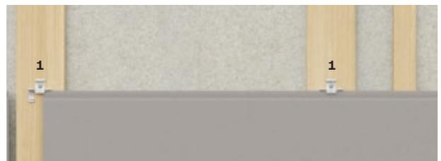
Der Abstand von der Stirnseite des Paneels bis zur Mitte des Montage-Clips darf 60 mm nicht überschreiten.
