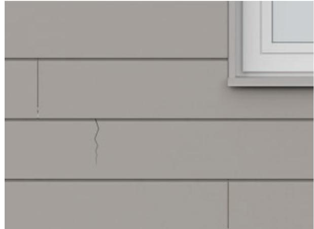
Das neue Paneel lässt sich einfach einsetzen, wenn man den hinteren Steg der Nut an der Paneelunterkante (1) entfernt. So kann das Paneel von unten nach oben eingeschoben werden.
