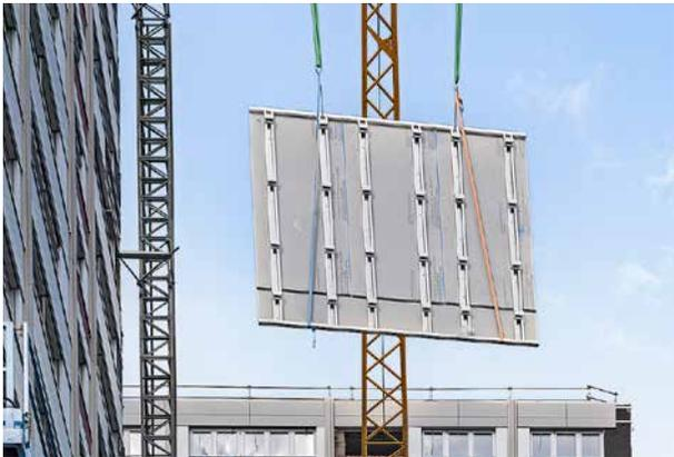
Afin de pouvoir assembler plus rapidement la façade sur place, les plaques de fibres-ciment furent posées et fixées en usine sur les cadres métalliques.
