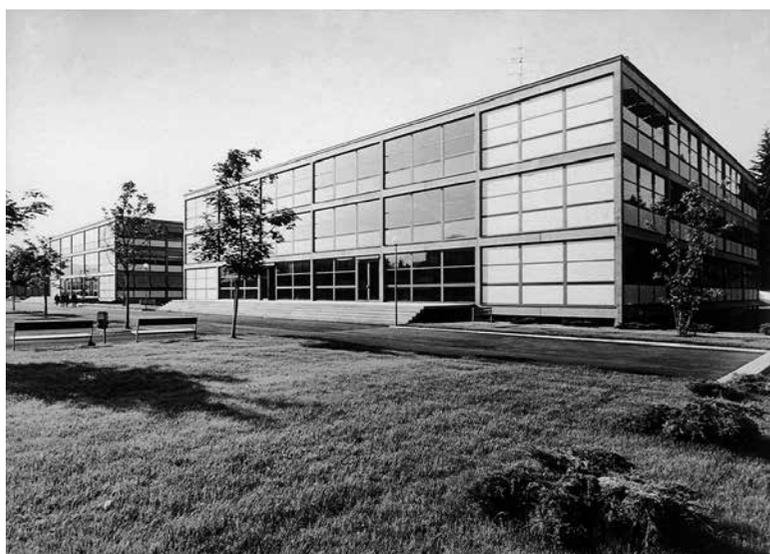
Les structures porteuses en béton peuvent être remplies avec divers matériaux, tant traditionnels que contemporains. Dans le cas des tours d'habitation INA-Casa à Rome, il s'agit d'éléments en béton creux et, dans celui des bâtiments de l'institut de l'université de Fribourg, de verre et de fibres-ciment.
