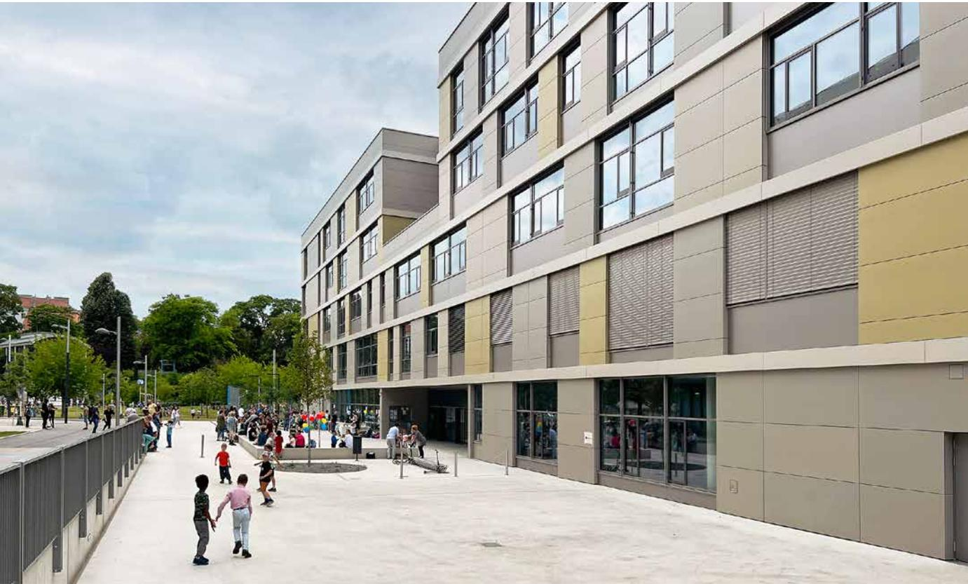
La façade s'articule en bandeaux horizontaux, séparés par des éléments de paroi habillés de fibres-ciment, ainsi que des éléments de fenêtre allant en partie du sol au plafond.
