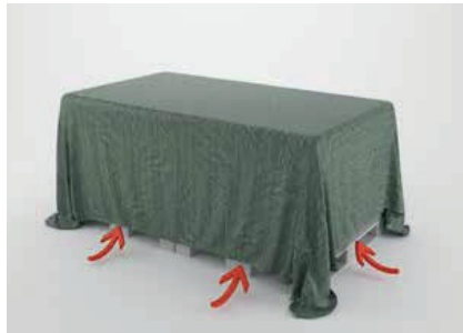
Seejärel tuleb tooted paigutada kuivale ja siledale alusele, vinn aga katta tendiga, mis kaitseb sademete eest ning tagab õhu vaba tsirkulatsiooni plaatide ümber.
