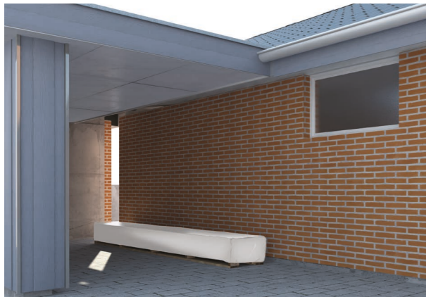
Jos tuotteita varastoidaan työmaalla yli 2-3 viikkoa, ne on säilytettävä katoksen alla. Päällekkäin voidaan varastoida enintään 4 lavaa.
