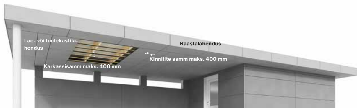
Kinnitite ja aluskarkasside vahekaugused
