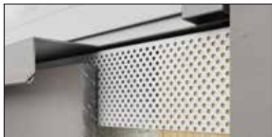
8 paveikslėlis „Swisspearl“ vėdinimo profilis
