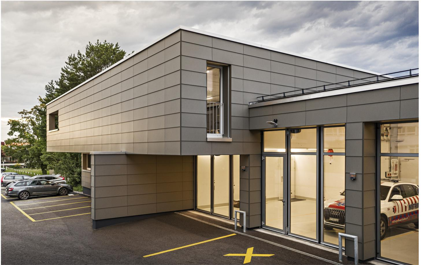
Der neue Rettungstrakt auf dem Areal des Spitals Lachen sieht nicht nur viel besser aus als der Alte, er ist auch funktionaler und ökologischer. Eine hinterlüftete Fassade mit guter Wärmedämmung und das Photovoltaikdach machen es möglich. Während im Innenausbau roh belassene oder farbbehandelte Oberflächen von Rohmaterialien dominieren, entschied man sich bei der Materialwahl für Fassade und Bedachung für eine Eternitverkleidung. Es war ein Entscheid für Langlebigkeit und geringen Unterhalt.
